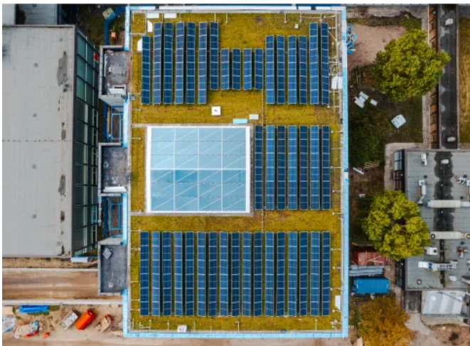
Ein Solargründach in der Praxis auf einem Gebäude der Universität Enschede © Optigrün
