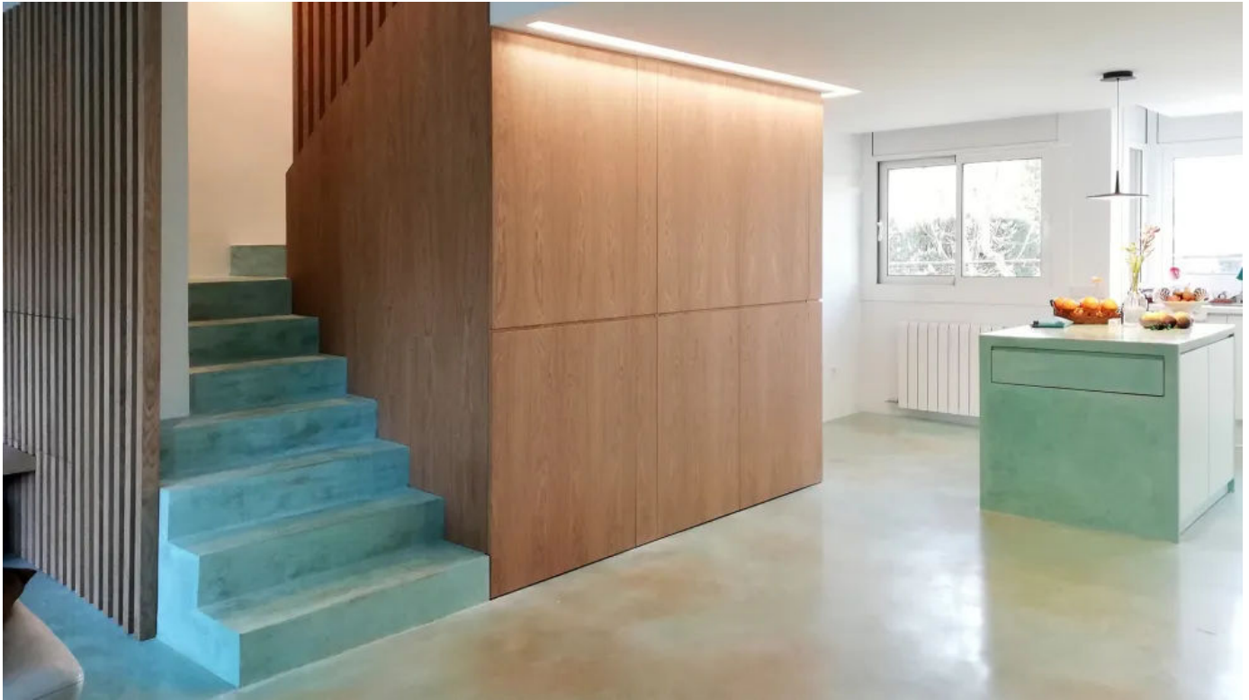
Auch Treppen lassen sich mit Acid-Stain-Dekorboden realisieren.
