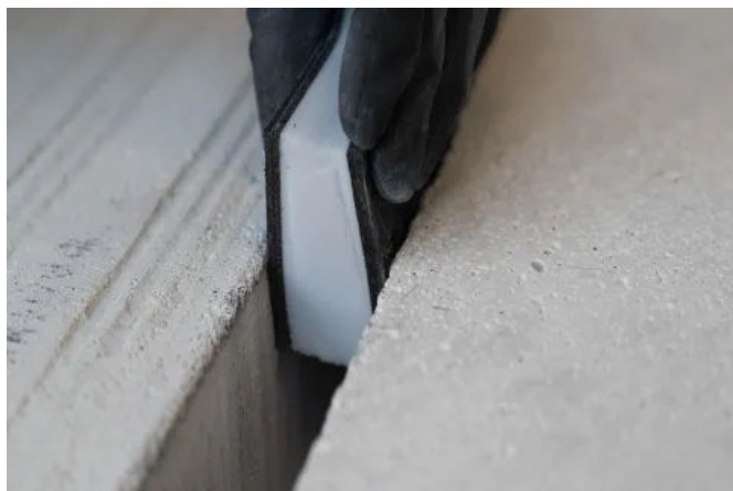
Das komprimierbare Rexpandit Brandschutz-Fugenelement wird klebfrei in die Fuge eingeklemmt, sodass die Fuge schallgedämmt und sofort rauchdicht ist.
