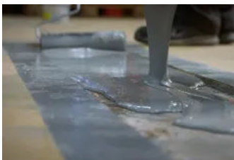
Füllung mit REVOPUR® Fugenliquid
