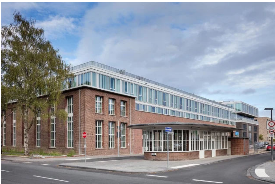
Clouth 104 Köln | Nach Schließung der Gummiwerke Clouth, lobte die Stadt Köln einen Wettbewerb aus. Das Ergebnis ist ein multifunktionaler Gebäudekomplex aus Bestands- und Neubauten, der auf Veränderungen eingestellt ist. Forster Profilsysteme lieferte Fenster und Türen nach historischem Vorbild.
