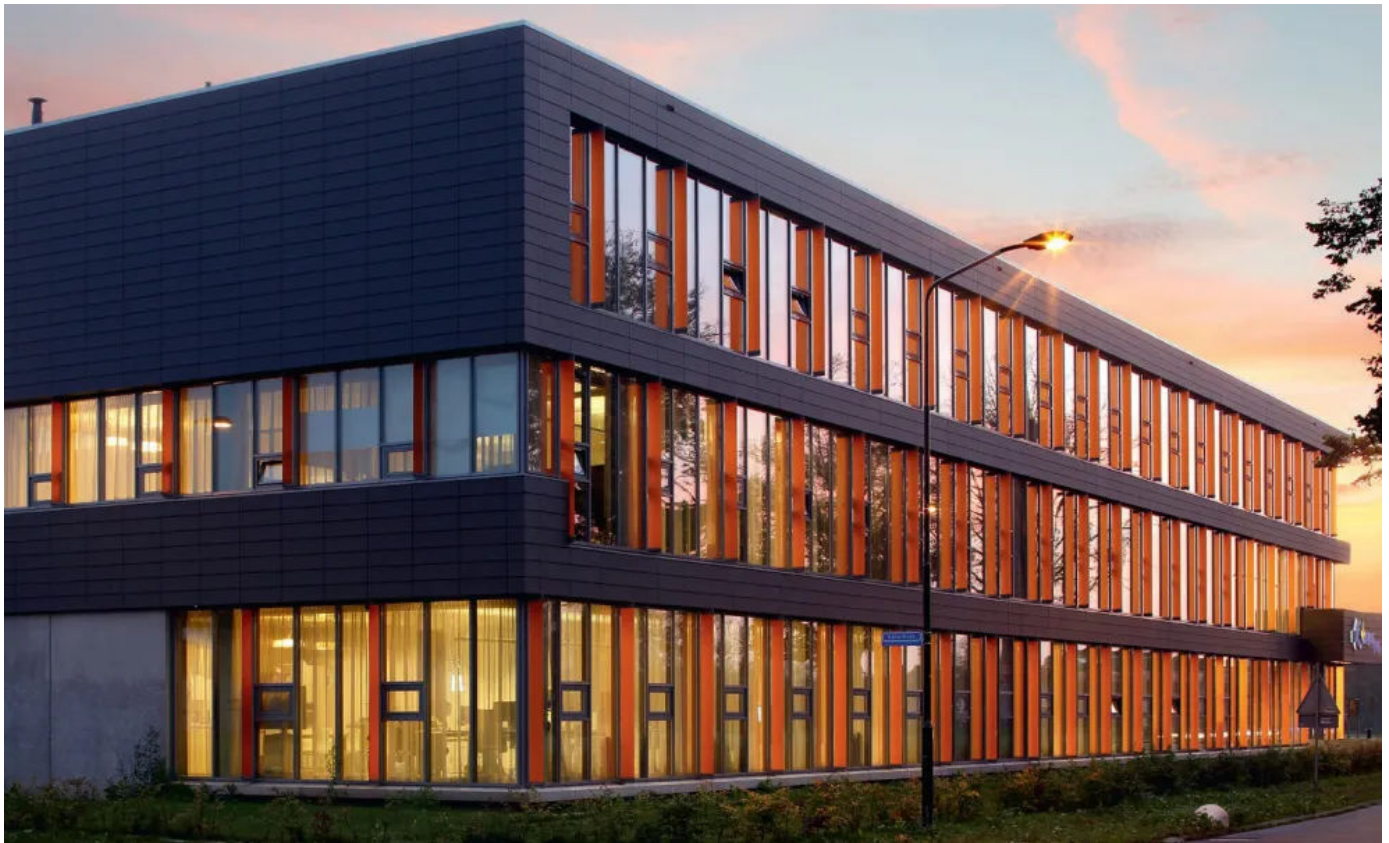
Wärmegeädämmte Pfosten-Riegel Fassade, Brandschutztüren und Verglasungen
