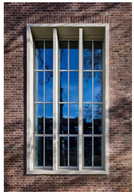
Clouth 104 Köln | Um den Charme der denkmalgeschützten Fassade zu erhalten, wurde bei der Modernisierung der Fenster und Türen das Ziel verfolgt, eine größtmögliche Annäherung an den Originalzustand zu erreichen.
