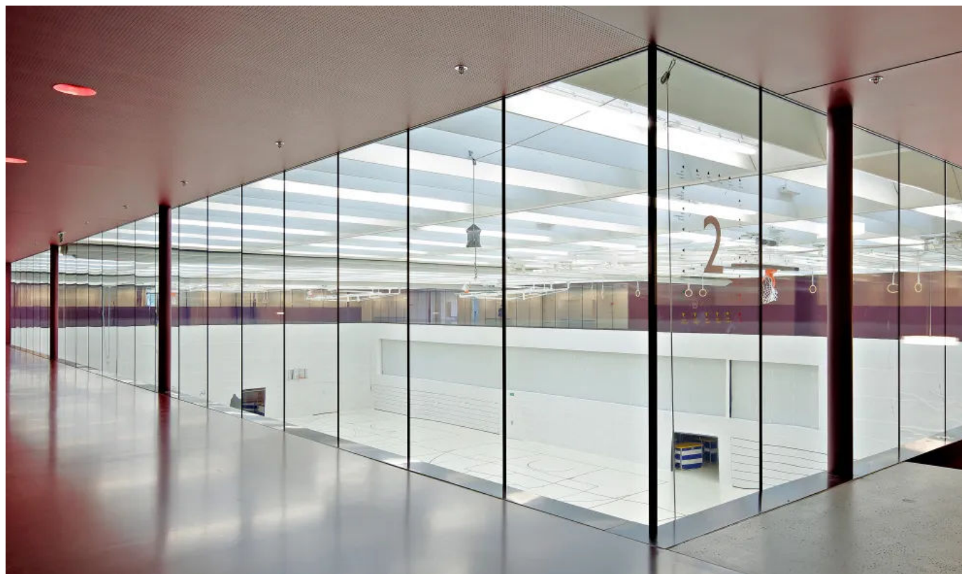
forster fuego light Stoßfugenverglasung Glas-Glas-Stoß EI30 / EI60
