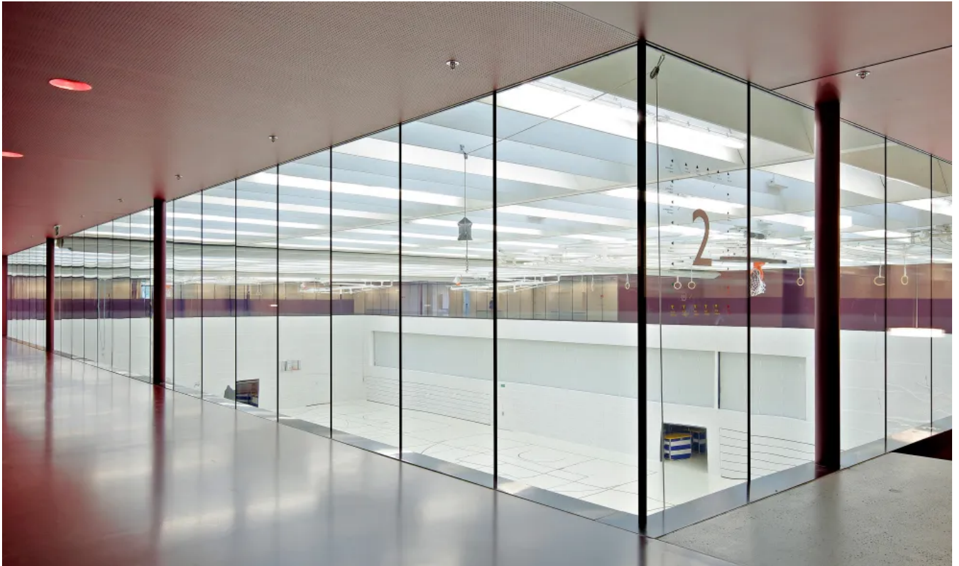
forster fuego light Stoßfugenverglasung Glas-Glas-Stoß EI30 / EI60
