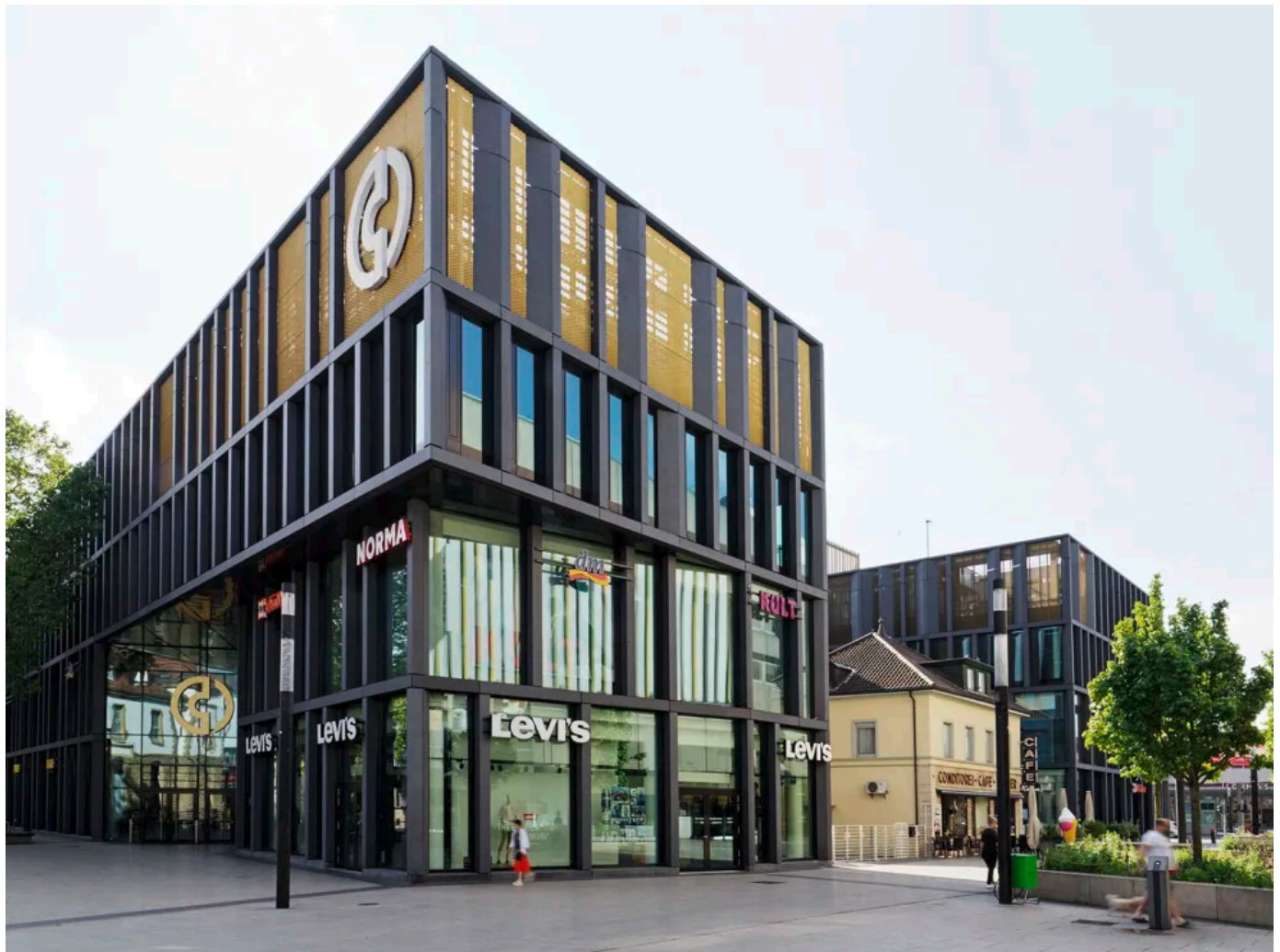
formparts geformte Fassadenelemente aus Glasfaserbeton am ECE Center, Singen (© Ditz Fejer)
