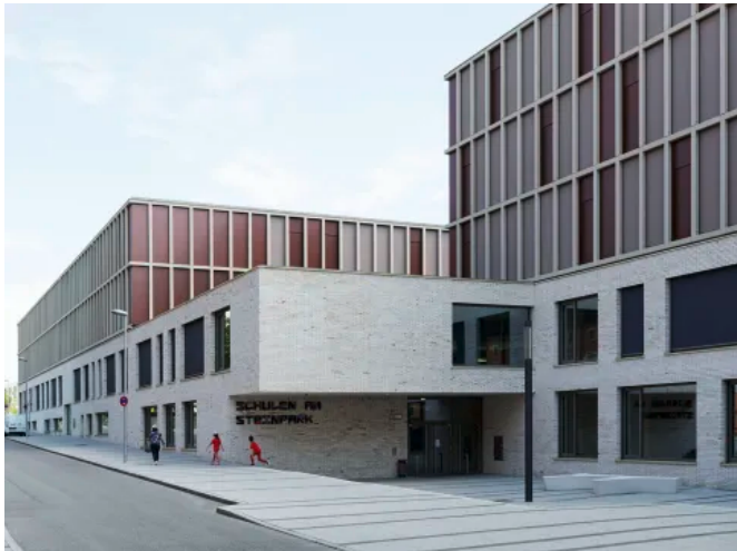
formparts geformte Fassadenelemente aus Glasfaserbeton an den Schulen am Steinpark, Freising (© Ditz Fejer)
