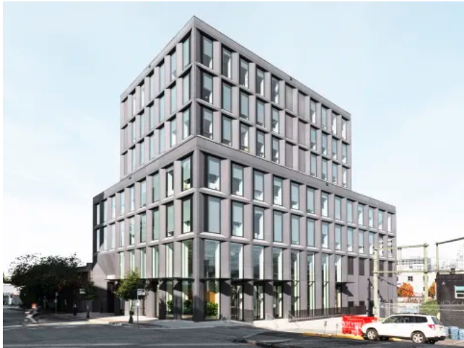
formparts geformte Fassadenelemente aus Glasfaserbeton an Büro- und Industriegebäude, Vancouver (© Ditz Fejer)
