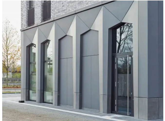
formparts geformte Fassadenelemente aus Glasfaserbeton am Bremer Spurwerk, Bremen (© Ditz Fejer)
