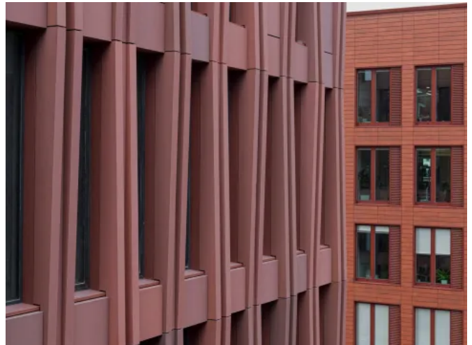
formparts geformte Fassadenelemente aus Glasfaserbeton am PREVIER Schulungszentrum, Hamburg
