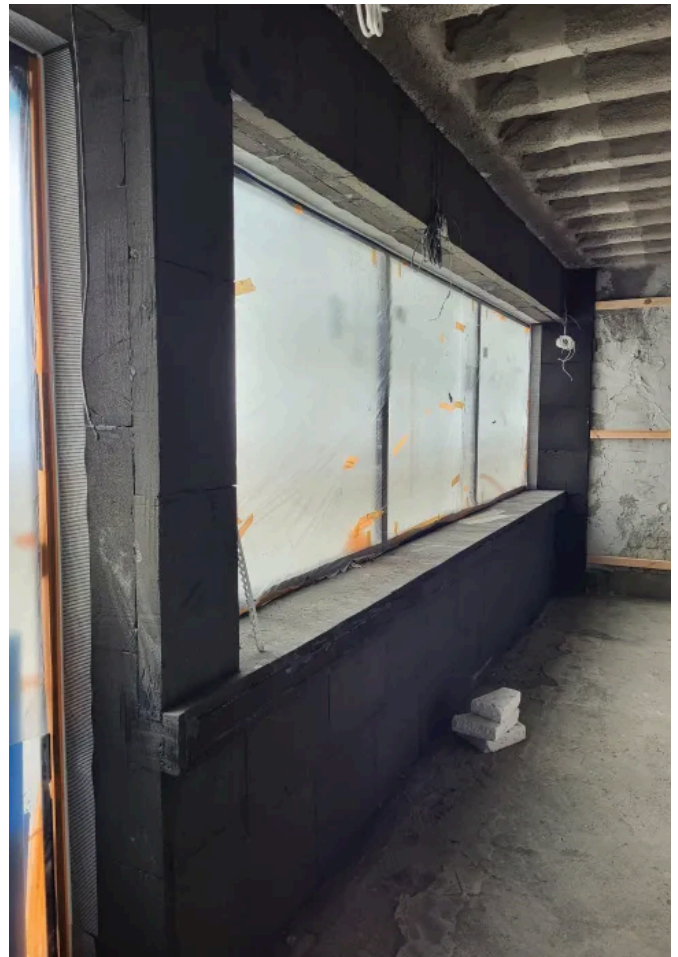
In Fensterlaibungen und Unterzügen ist eine Dämmstoffdicke von 40 mm vorgesehen. (© OC FOAMGLAS®)
