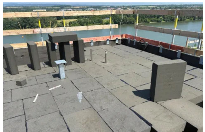
Foamglas T3+ weist eine Wärmeleitfähigkeit von 0,036 \text{ W/(m}\cdot\text{K)} auf und ist der Baustoffklasse A1 zugeordnet. Damit erfüllt das Material energetische sowie brandschutztechnische Anforderungen. (© KOCH Bedachungen GmbH)
