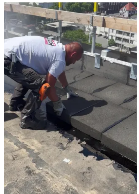
Foamglas T3+ weist eine Rohdichte von ca. 95 kg/m³ und eine hohe Druckfestigkeit auf. Dadurch ist der Einsatz auf Flachdächern sowie in Bereichen mit statischer Beanspruchung möglich. (© KOCH Bedachungen GmbH)
