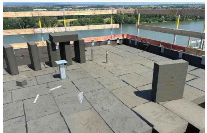
Foamglas T3+ weist eine Wärmeleitfähigkeit von 0,036 W/(m·K) auf und ist der Baustoffklasse A1 zugeordnet. Damit erfüllt das Material energetische sowie brandschutztechnische Anforderungen. (© KOCH Bedachungen GmbH)
