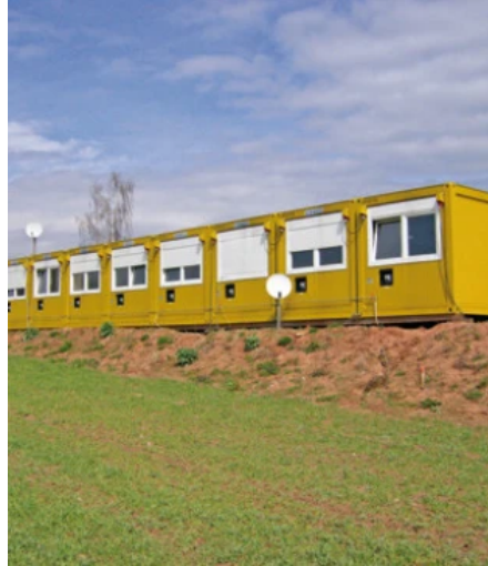
Versorgung einer Containeranlage mit 36 Wohn- und Sanitärcontainern
