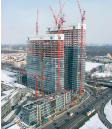
Winterbaubeheizung von zwei Hochhäusern, einem Büro- und einem Hotelkomplex
