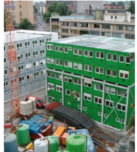
Versorgung einer Containeranlage mit 144 Büro- und Tagesunterkuntscontainern
