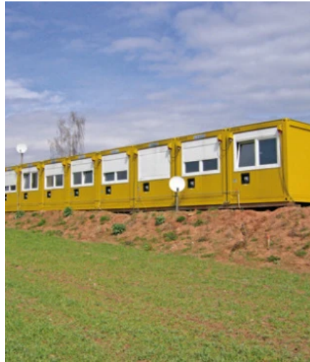
Versorgung einer Containeranlage mit 36 Wohn- und Sanitärcontainern
