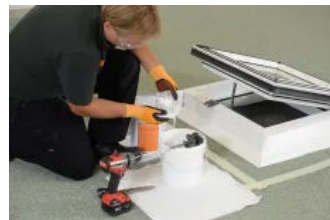
Katalysator zugeben nur beim 2-komponentigen-System
