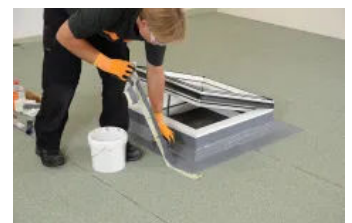
Klebeband entfernen
