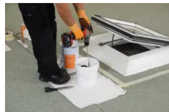
Flüssigkunststoff anrühren
