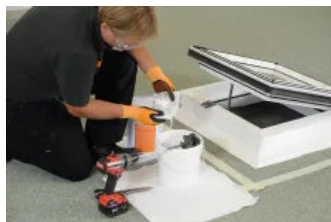
Katalysator zugeben nur beim 2-komponentigen-System
