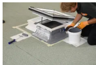
Zweite Schicht auftragen
