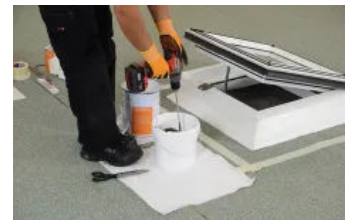
Flüssigkunststoff anrühren
