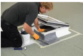
Erste Schicht auftragen
