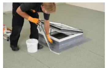
Klebeband entfernen
