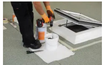
Flüssigkunststoff anrühren
