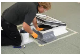
Erste Schicht auftragen
