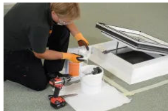
Katalysator zugeben nur beim 2-komponentigen-System
