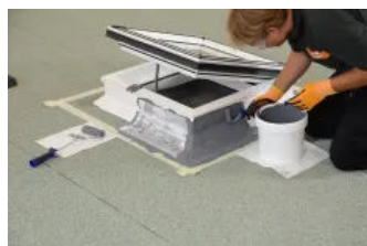
Zweite Schicht auftragen
