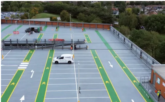
Beschichtungssysteme für Parkhaus-Freidecks
