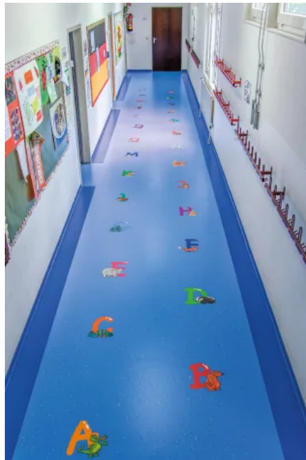
Sanierter und neugestalteter Boden mit Motiven
