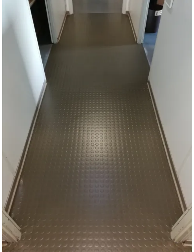
Nachher: renovierter Boden im alten Design, Optik wie neu
