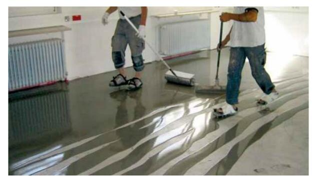
Fließspachtelmasse, Premiumspachtelmasse, fasergestärkter Fließspachtel und Calciumsulfatgebundener Fließspachtel
