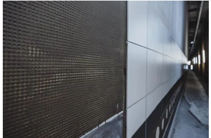
Bei der Sanierung wurden die Wände in den Ein- und Ausfahrtsbereichen der ersten Röhre mit neuen Keramikfliesen verkleidet.
