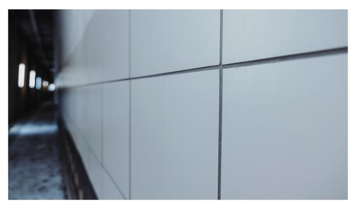
Fliesen im Außenbereich sicher verlegen: Die Fliesenverlegung im Verbund mit hochbelastbaren codex Systemkomponenten ermöglicht Fliesen unter Extrembelastung. Der zweikomponentige, hoch flexible Dünnbettmörtel codex Power RX 11 Outdoor ist speziell für Fliesen im Außenbereich konzipiert. Feinsteinzeug bis 120 cm Kantenlänge als auch Natur- und Betonwerksteinplatten werden – innen wie außen – sicher verlegt.
