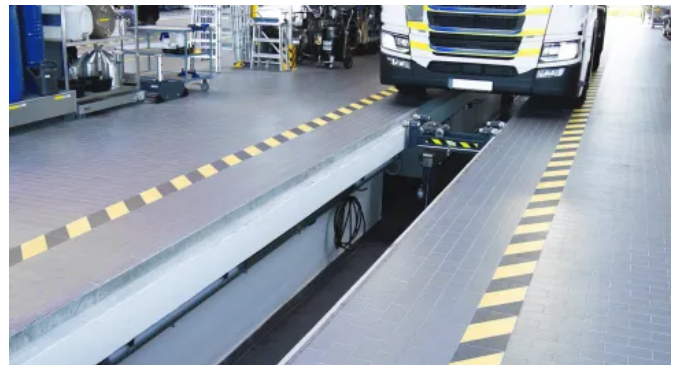
Rechteckige Industriefliesen in einer Nutzfahrzeug Werkstatt
