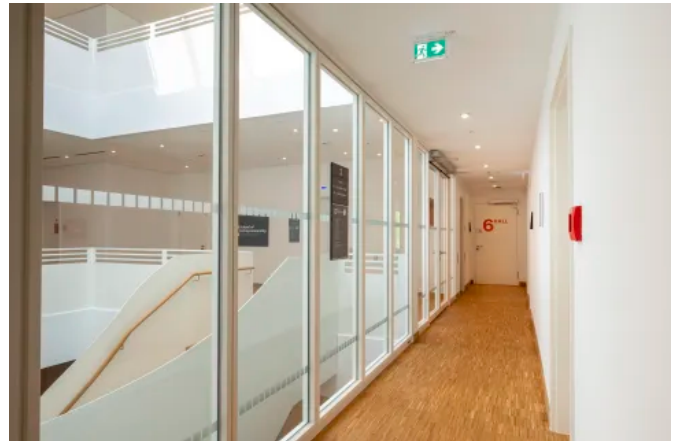
Trennwand T46 - Brandschutzverglasung
