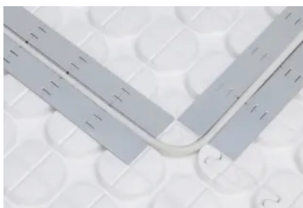
Wärmeleitmodule und Rohre werden in den Trockenbauplatten fixiert.
