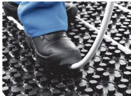
Fest definierte Verlegeabstände können eingehalten werden.
