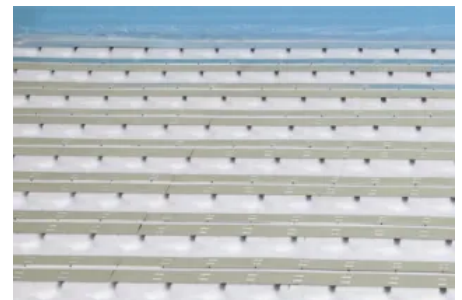
Die Fläche kann sofort mit Trockenestrich belegt werden.
