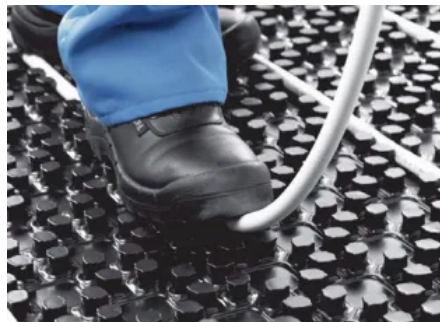
Fest definierte Verlegeabstände können eingehalten werden.
