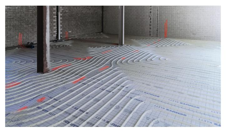
Das Klettsystem ermöglicht eine schnelle und unkomplizierte Verlegung. Das Deckschichtmaterial sorgt für maximalen Halt durch eine Verzahnung von Heizrohr und Systemdämmplatte. Eine Lagekorrektur der Rohre ist dabei jederzeit rückstandslos möglich. Damit alle Rohre im richtigen Abstand und gerade liegen, bietet die Maßeinteilung auf der Dämmplatte eine einheitliche Orientierungshilfe.
