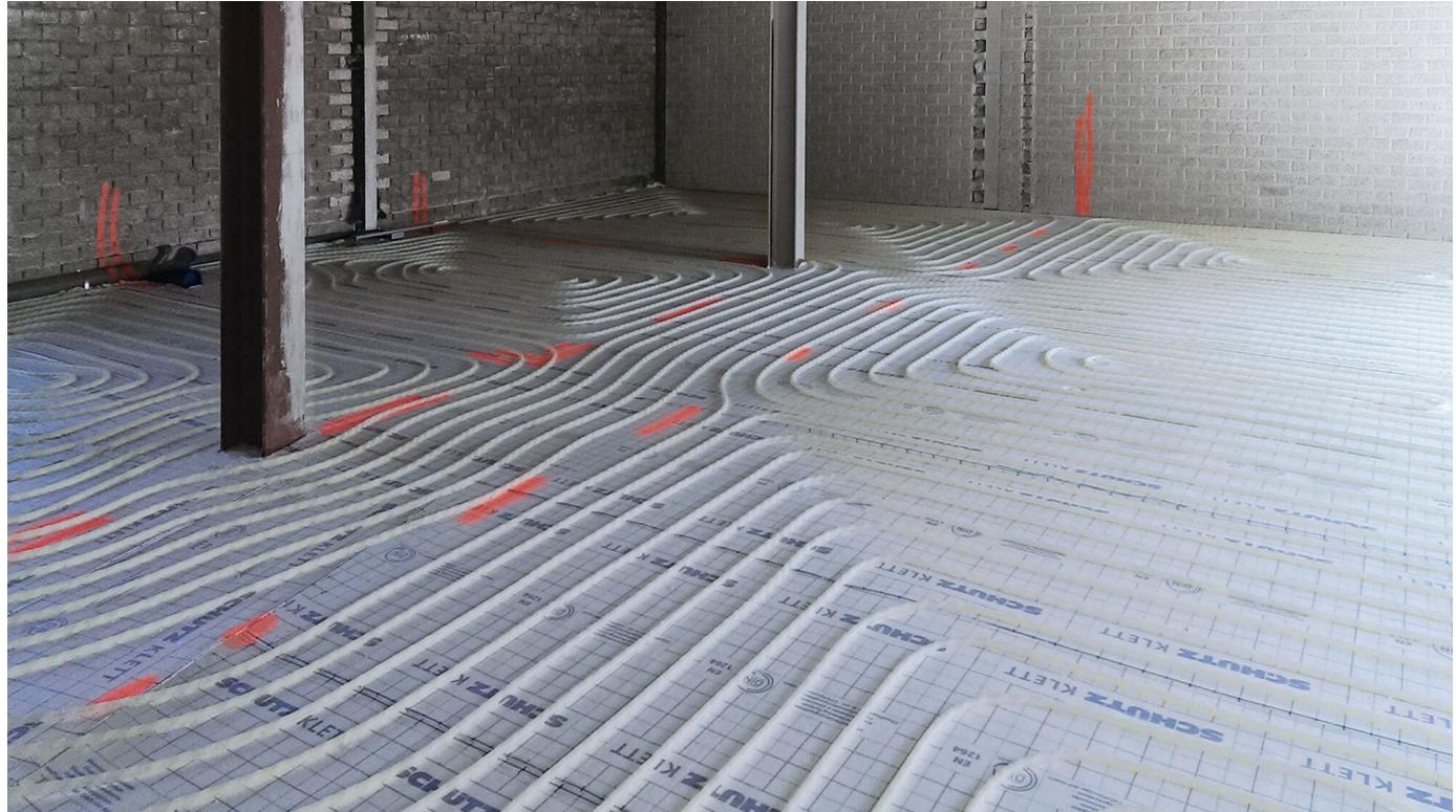
Das Klettsystem ermöglicht eine schnelle und unkomplizierte Verlegung. Das Deckschichtmaterial sorgt für maximalen Halt durch eine Verzahnung von Heizrohr und Systemdämmplatte. Eine Lagekorrektur der Rohre ist dabei jederzeit rückstandslos möglich. Damit alle Rohre im richtigen Abstand und gerade liegen, bietet die Maßeinteilung auf der Dämmplatte eine einheitliche Orientierungshilfe.
