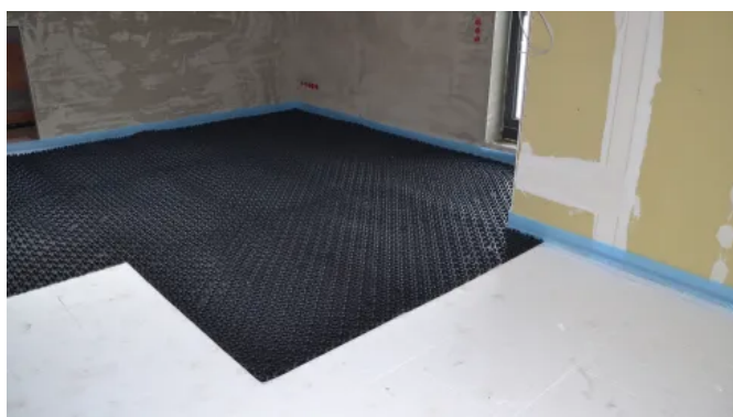
BLANKE PERMATOP: Verlegebeispiel
