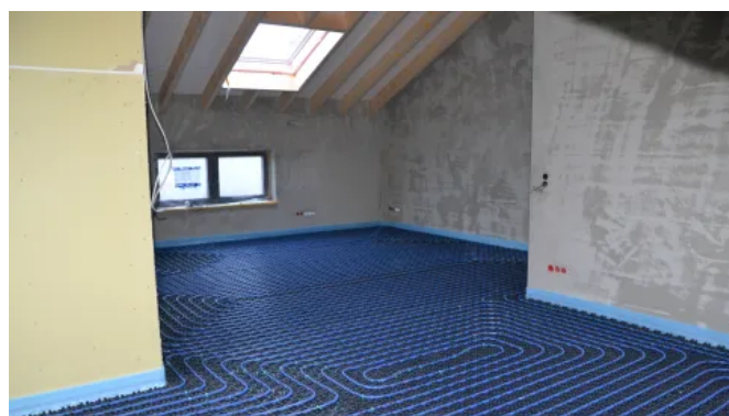
BLANKE PERMATOP: Verlegebeispiel
