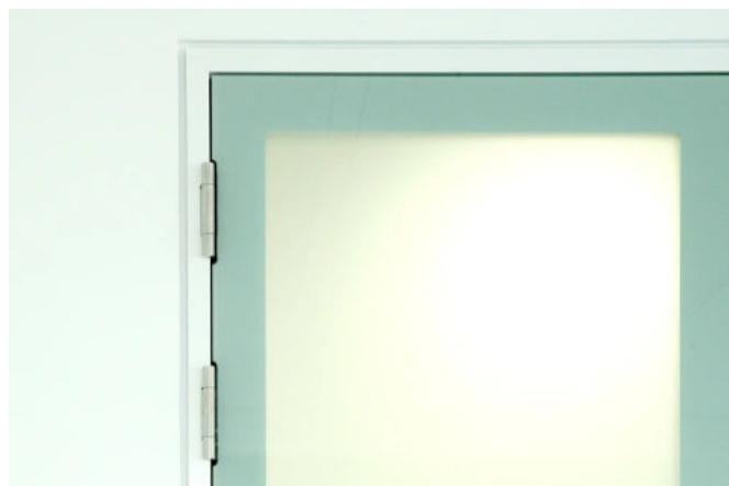
Schattennut-Zarge mit flächenbündiger Glástür
