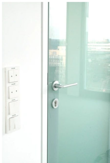
Glasverbundtür mit Rosetten-Türrückergarnitur, flächenbündige Zarge mit Schattennut
