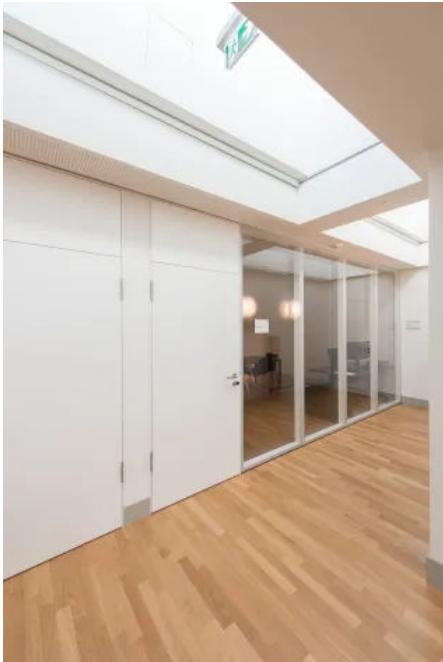
Verglasung und Türelement in einer Ebene
