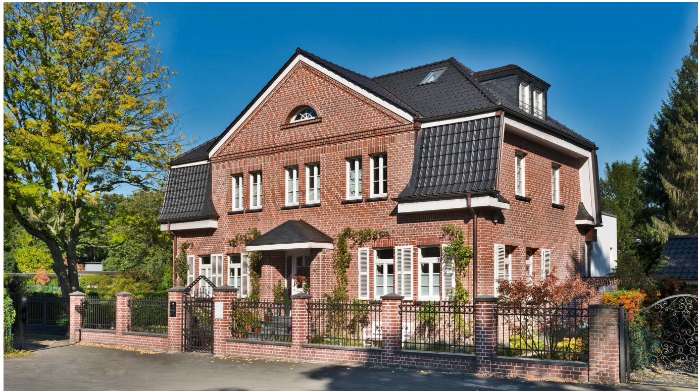
Die Flachdachziegel TIEFA sind mit der intensiven Verriegelung im Vierzeckeck (vierfache Überdeckung) und dem speziellen Verfalzungssystem (Tiefe Falz) besonders sicher gegen Schlagregen, Flugschnee und Windsog.
