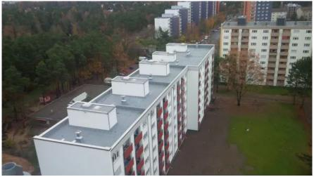
Zweilagige Abdichtung aus Polymerbitumenbahnen
