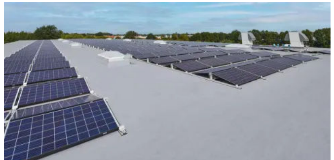
Regeneration der Dachhaut im Zuge baulicher Veränderungen
