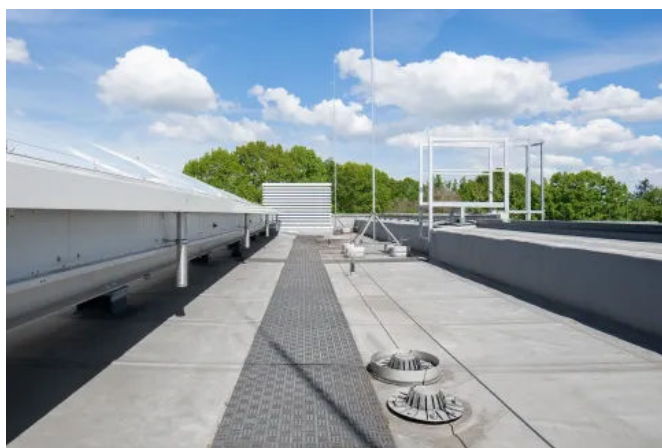
Fächerbad Karlsruhe | © ACO Haustechnik (© Daniel Wieser . Architekturfotografie, Karlsruhe)
