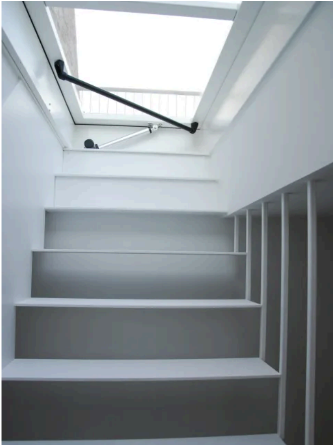
Nach der Montage der Luke auf dem Dach wird der Stecker an das Stromnetz angeschlossen und die Luke ist gebrauchsfertig.
