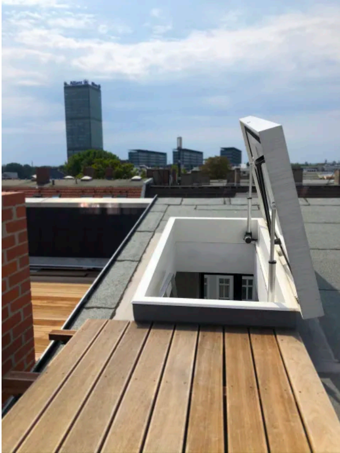
Das Öffnen des Flachdachausstieges mit Glas erfolgt einfach per Knopfdruck.
