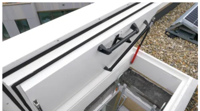
ThermoTop Flachdachausstieg mit Scherentreppe
