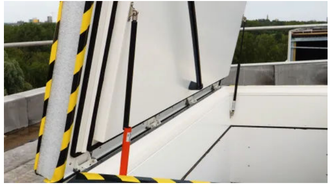
Der Deckel öffnet und schließt mittels Gasdruckfedern.
