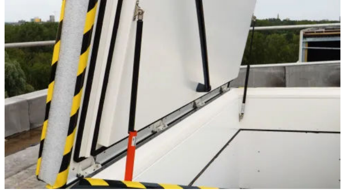
Der Deckel öffnet und schließt mittels Gasdruckfedern.
