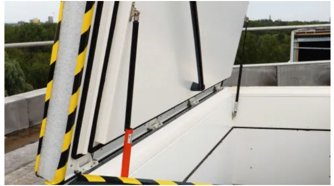
Der Deckel öffnet und schließt mittels Gasdruckfedern.
