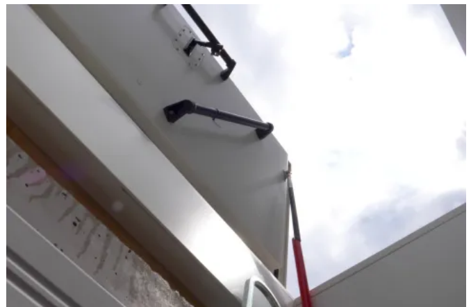
Staka Flachdachausstiege sind einfach zu montieren, auch in Kombination mit Leiter oder Treppe.
