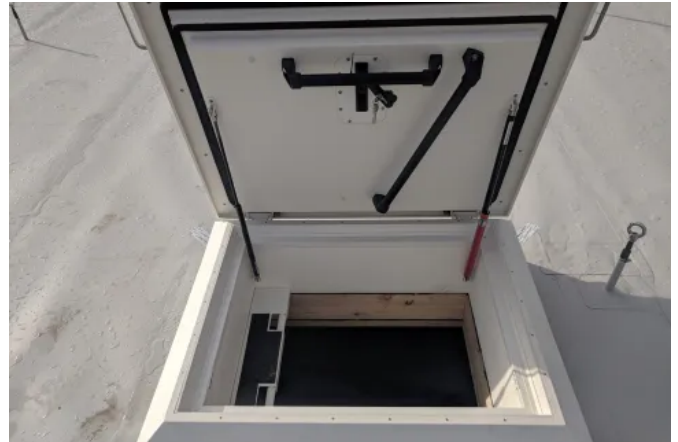
ThermoTop ist der erste Flachdachausstieg mit effektiver thermisch getrennter Konstruktion.
