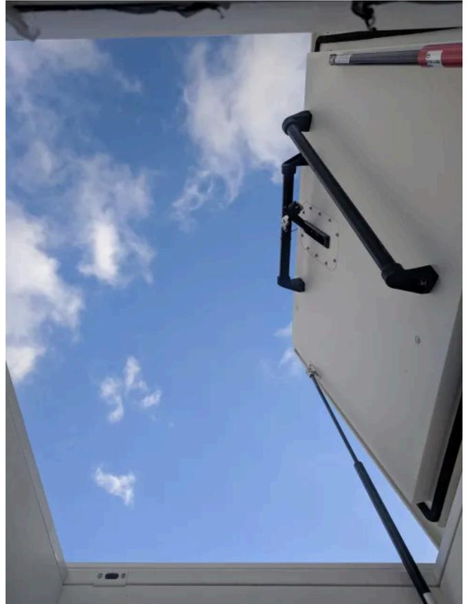
Der Flachdachausstieg ThermoTop mit thermisch getrennter Konstruktion erzielt einen U-Wert von 0,21 W/m<sup>2</sup>-K.
