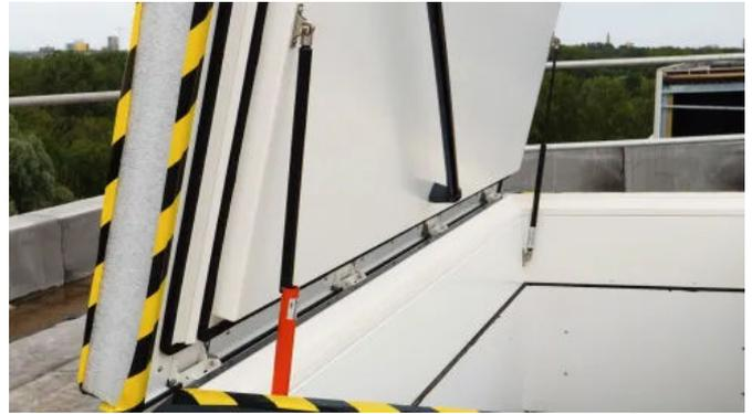
Der Deckel öffnet und schließt mittels Gasdruckfedern.
