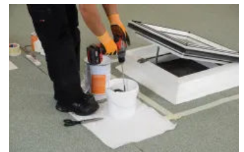
Flüssigkunststoff anrühren
