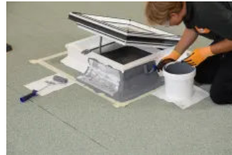
Zweite Schicht auftragen
