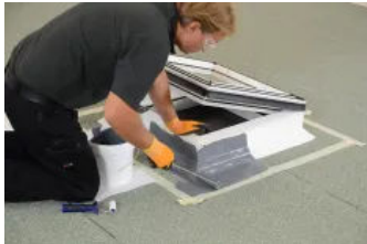
Erste Schicht auftragen
