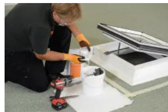
Katalysator zugeben nur beim 2-komponentigen-System
