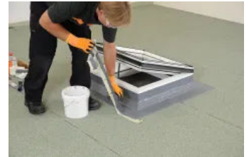
Klebeband entfernen
