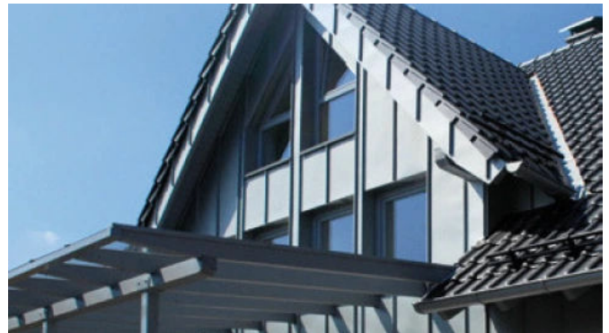
Scharen in Stehfalztechnik
