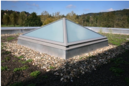
Flachdach Fenster FE Pyramide Mehrzweckturnhalle in Hersbrück
