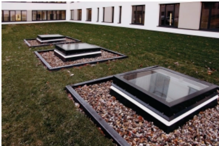
LAMILUX Flachdach Fenster FE 3° Helios Klinikum Aue
