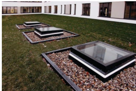
LAMILUX Flachdach Fenster FE 3° Helios Klinikum Aue
