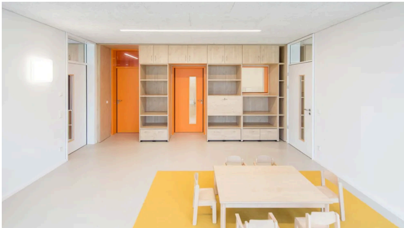
Türelemente mit Oberlicht, Lichtausschnitt und Klemmschutzlösung für Kinderfinger
