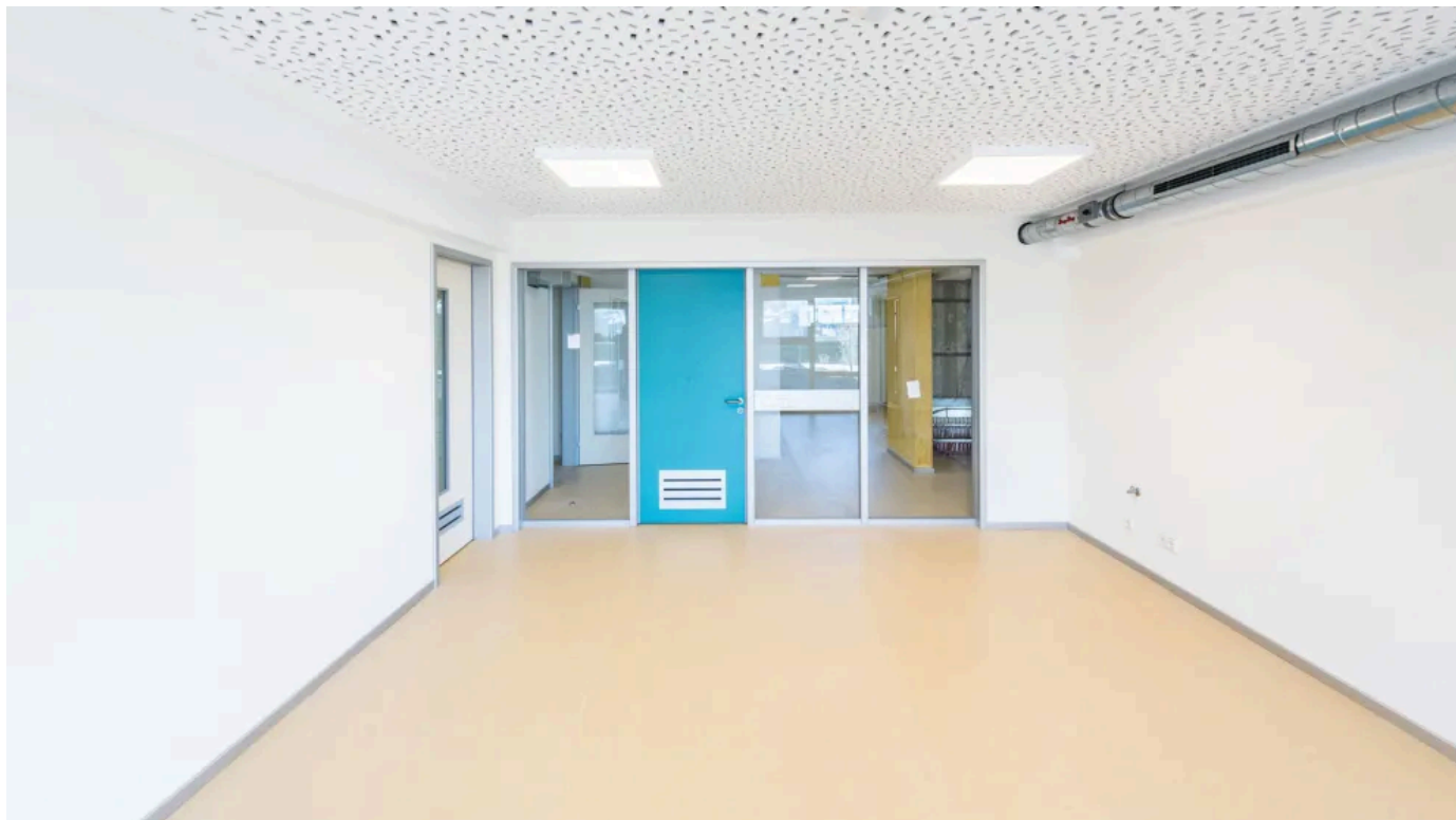
Türblatt mit Nachströmöffnung
