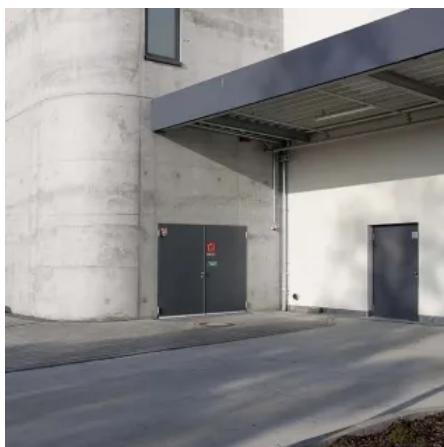
Die Außen-Feuerschutztür EI<sub>2</sub> 30-C5-S<sub>a</sub> "Teckentrup 62" verfügt über die europäische Zulassung. Sie ist klassifiziert nach der Produktnorm EN 16034 / EN 14351-1 (Außenanwendung).
