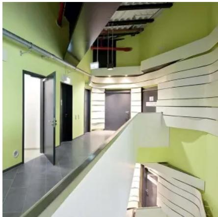
Die hochfeuerhemmende T60-FSA 62 Stahltür ist geprüft nach DIN 4102 (EN 1634-1).
