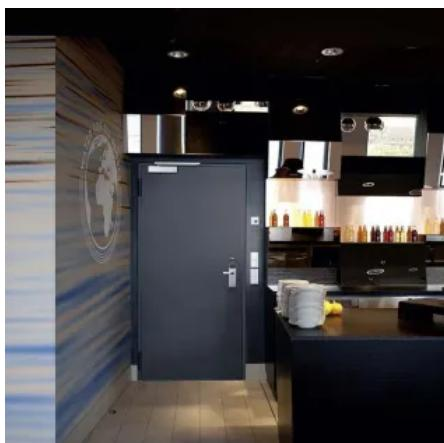
Die T30-1/2-FSA "62" Stahl-Feuerschutztür ist geprüft nach EN 1634-1 (DIN 4102).
