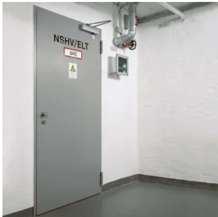
Die Stahltür T30 "HT 8-D" ist geprüft nach EN 1634-1 (DIN 4102). Es handelt sich um ein einflügeliges Türelement, das links/rechts verwendbar ist.
