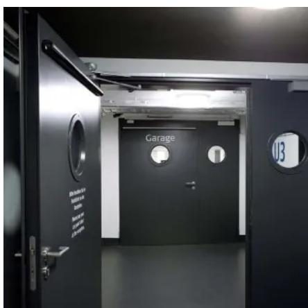
Die T90-1/2-FSA "62" Stahl-Feuerschutztür ist geprüft nach EN 1634-1 (DIN 4102).
