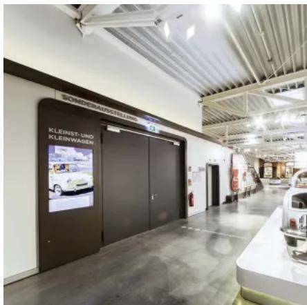
Die "T30-1/2-FSA 42" Stahl-Feuerschutztür ist geprüft nach DIN 4102 (EN 1634-1).
