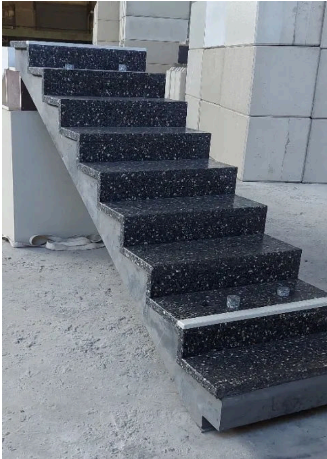
Fertigteiltreppe mit Belagstufen aus Betonwerkstein, feingeschliffen.
