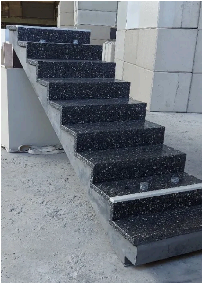
Fertigteiltreppe mit Belagstufen aus Betonwerkstein, feingeschliffen.
