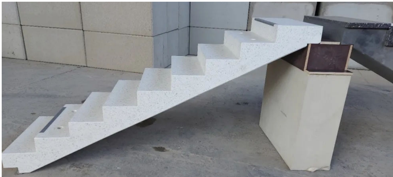
Fertigteiltreppe mit Vorsatz – Rezeptur Carrara-weiß, feingeschliffen
