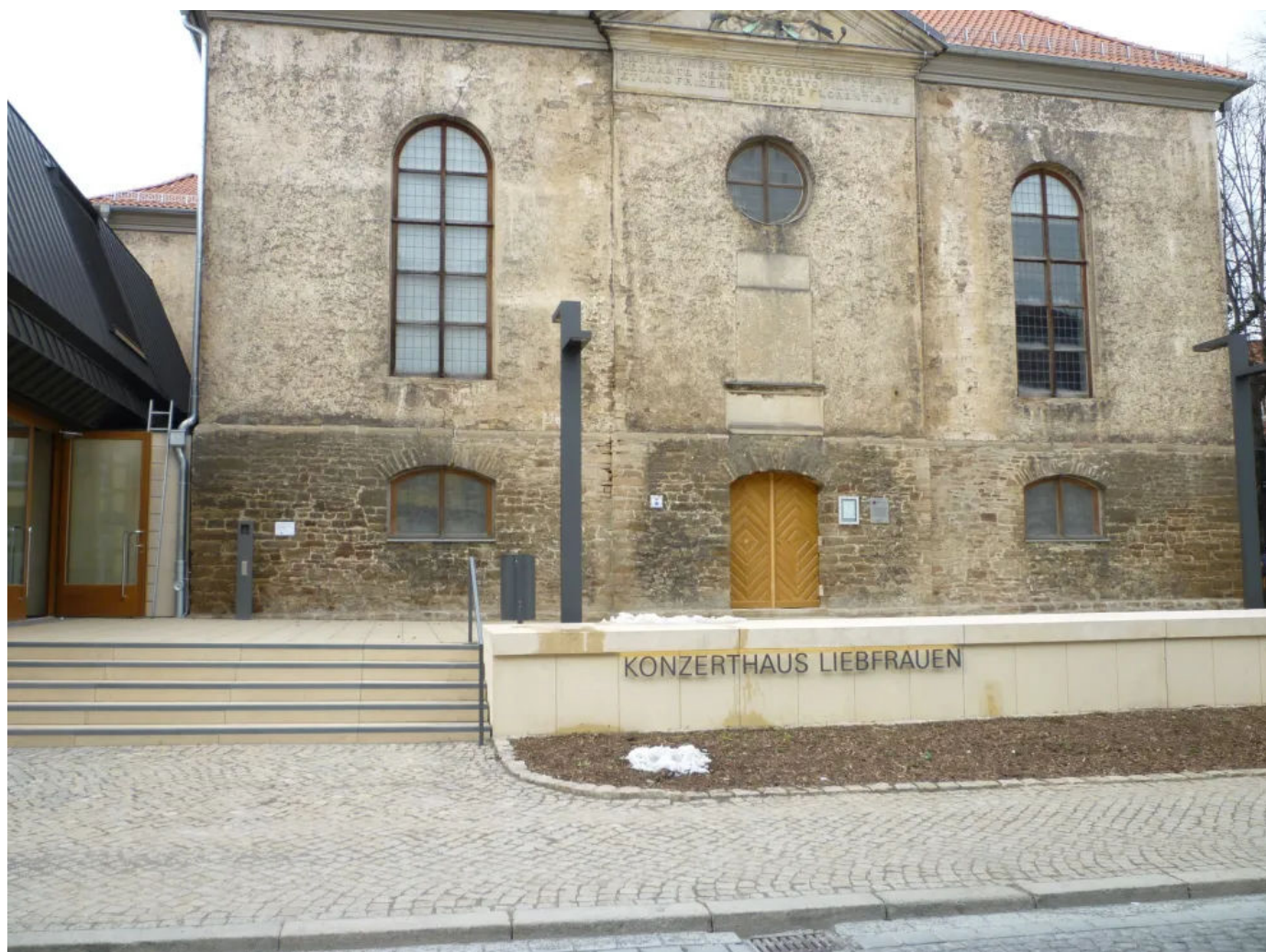
Konzerthaus Liebfrauen | Fertigteiltreppe
