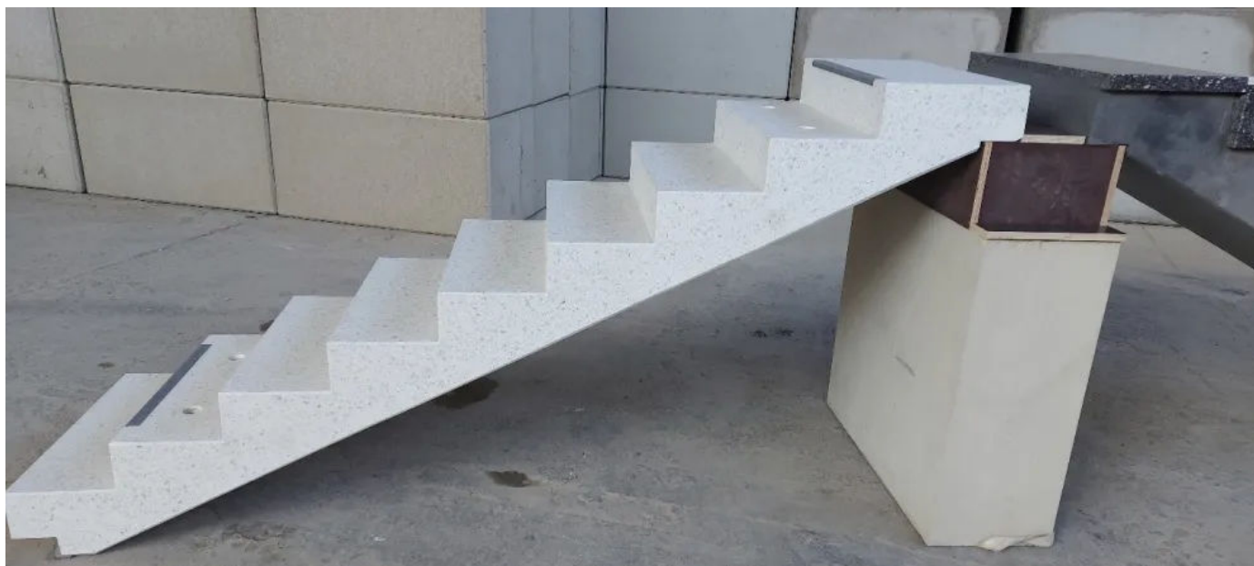
Fertigteiltreppe mit Vorsatz – Rezeptur Carrara-weiß, feingeschliffen
