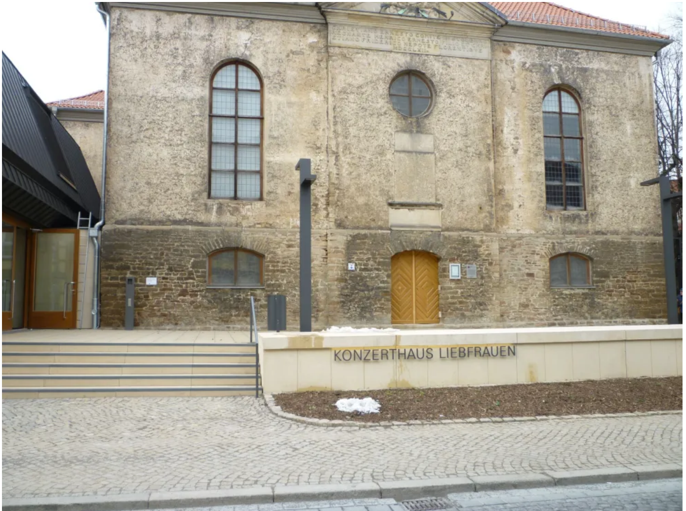
Konzerthaus Liebfrauen | Fertigteiltreppe
