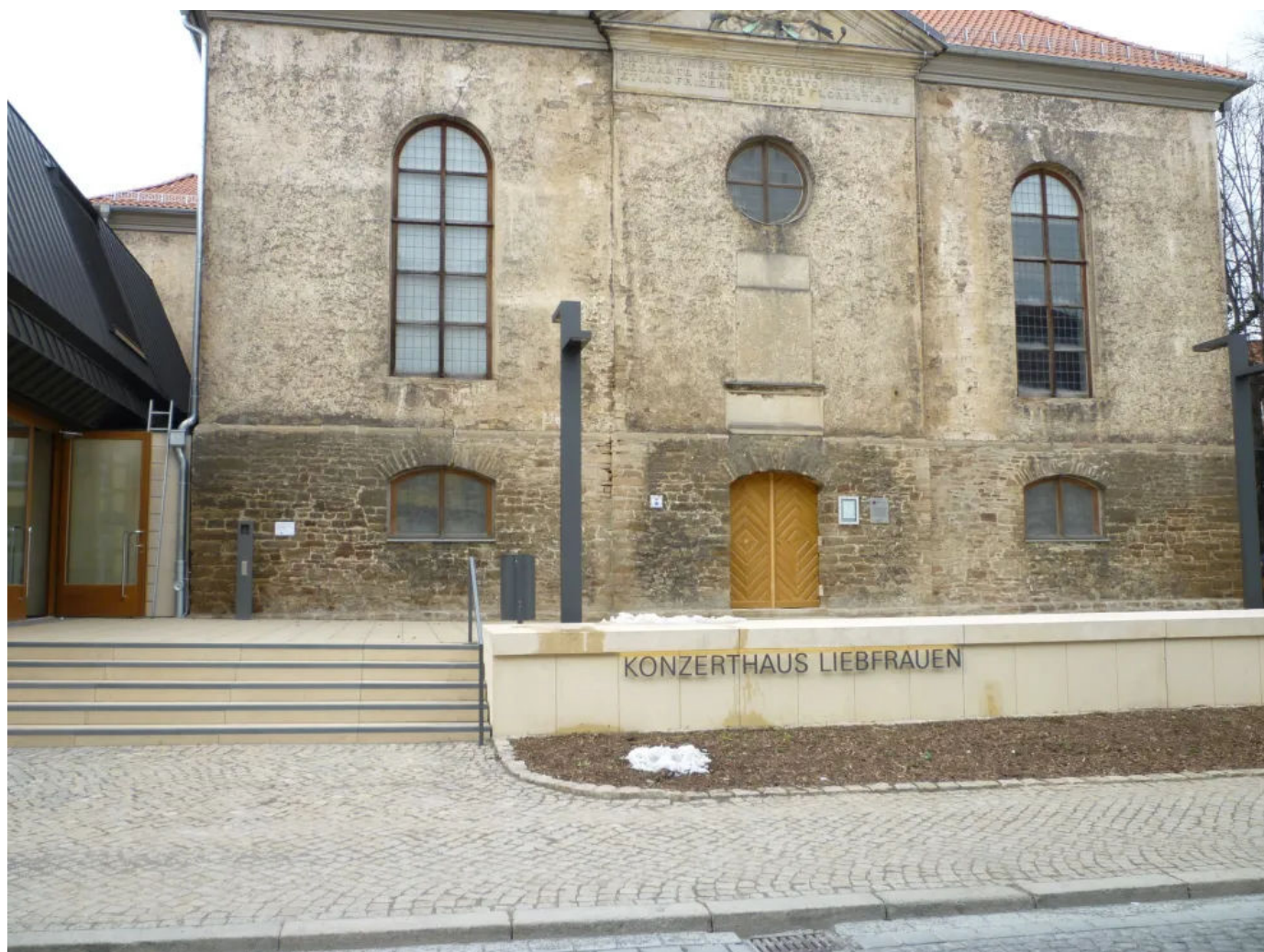
Konzerthaus Liebenfrauen | Fertigteiltreppe
