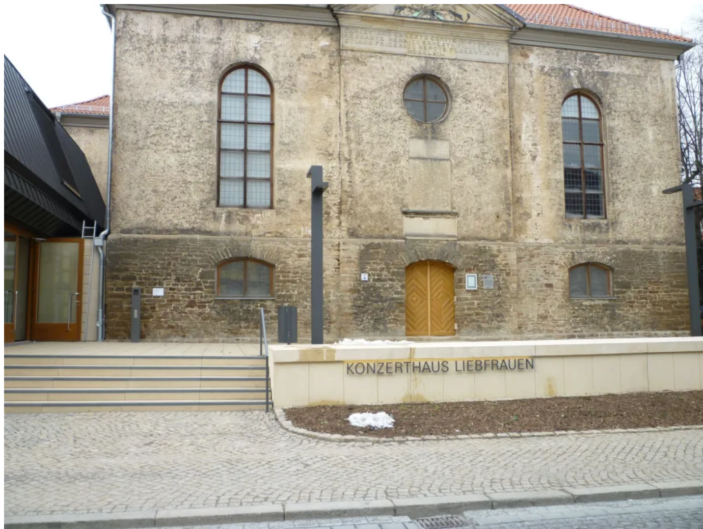
Konzerthaus Liebfrauen | Fertigteiltreppe
