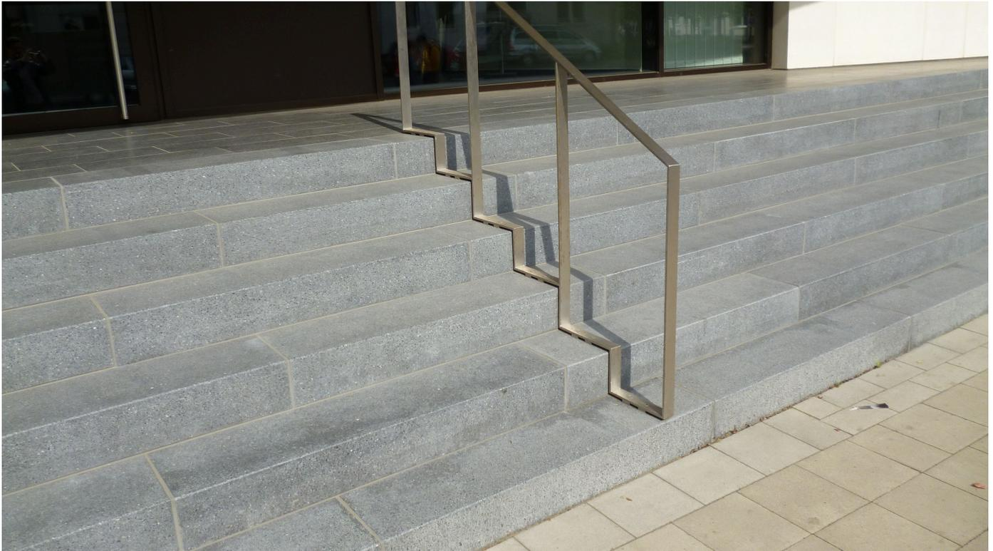
Das Unternehmen produziert Fertigteiltreppen aus Beton für den Innen- und Außenbereich in gerader und gewendelter Form. Gerade Elementtreppen werden als Standard / Rohtrappe oder als Treppe in hochwertiger Strahlschalung hergestellt.
