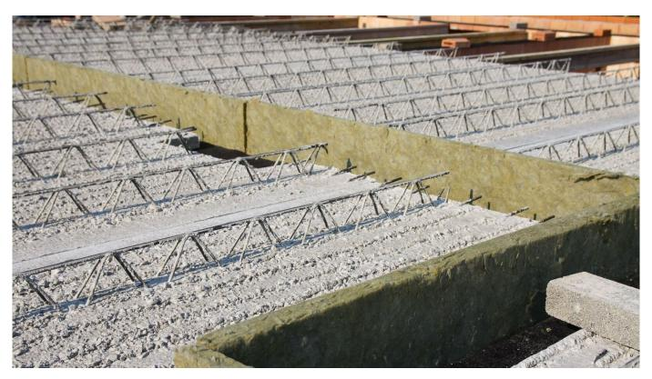
Betonfertigteile – Deckenplatten mit Ortbetonergänzung für Geschoss- und Dachdecken
