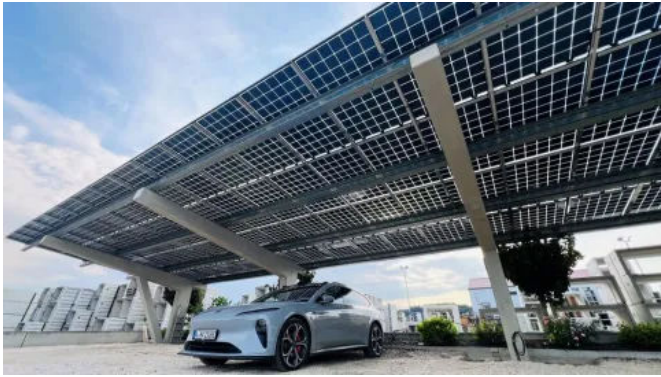
Einsatz der Fertigfundamente im Solarpark Wörleschwang
