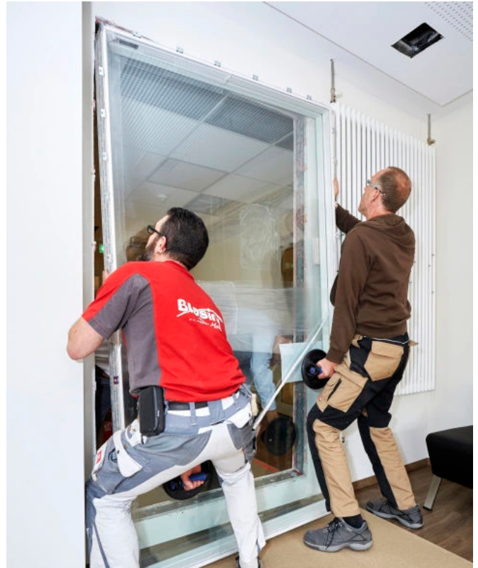
Knauf FireWin, das Fertigfenster für den Trockenbau mit Brandschutz, lässt sich unkompliziert und schnell einbauen.
