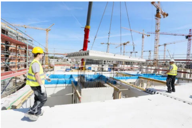
Schnelle Geschossdecke (© Hardy Welsch)
