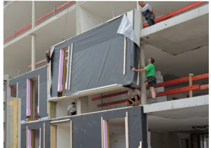
Hybridbau mit nichttragender Fassadenkonstruktion aus vorgefertigten Holzbauerelementen
