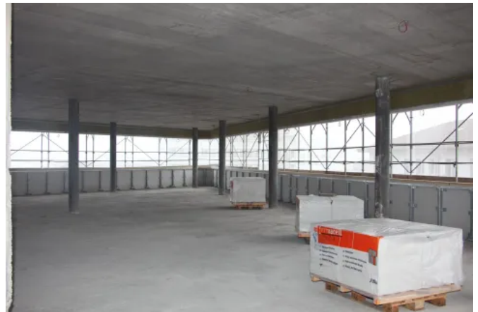
Hybridbau – Fassade aus nichttragenden vorelementierten Holzbaulementen - fermacell® Gipsfaserplatten 12,5 mm und 18 mm
