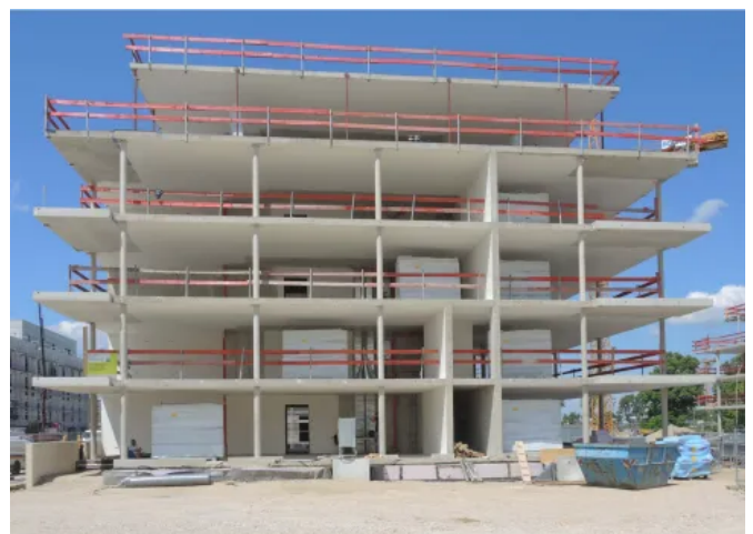
Hybridbau mit nichttragender Fassadenkonstruktion aus vorgefertigten Holzbauerelementen
