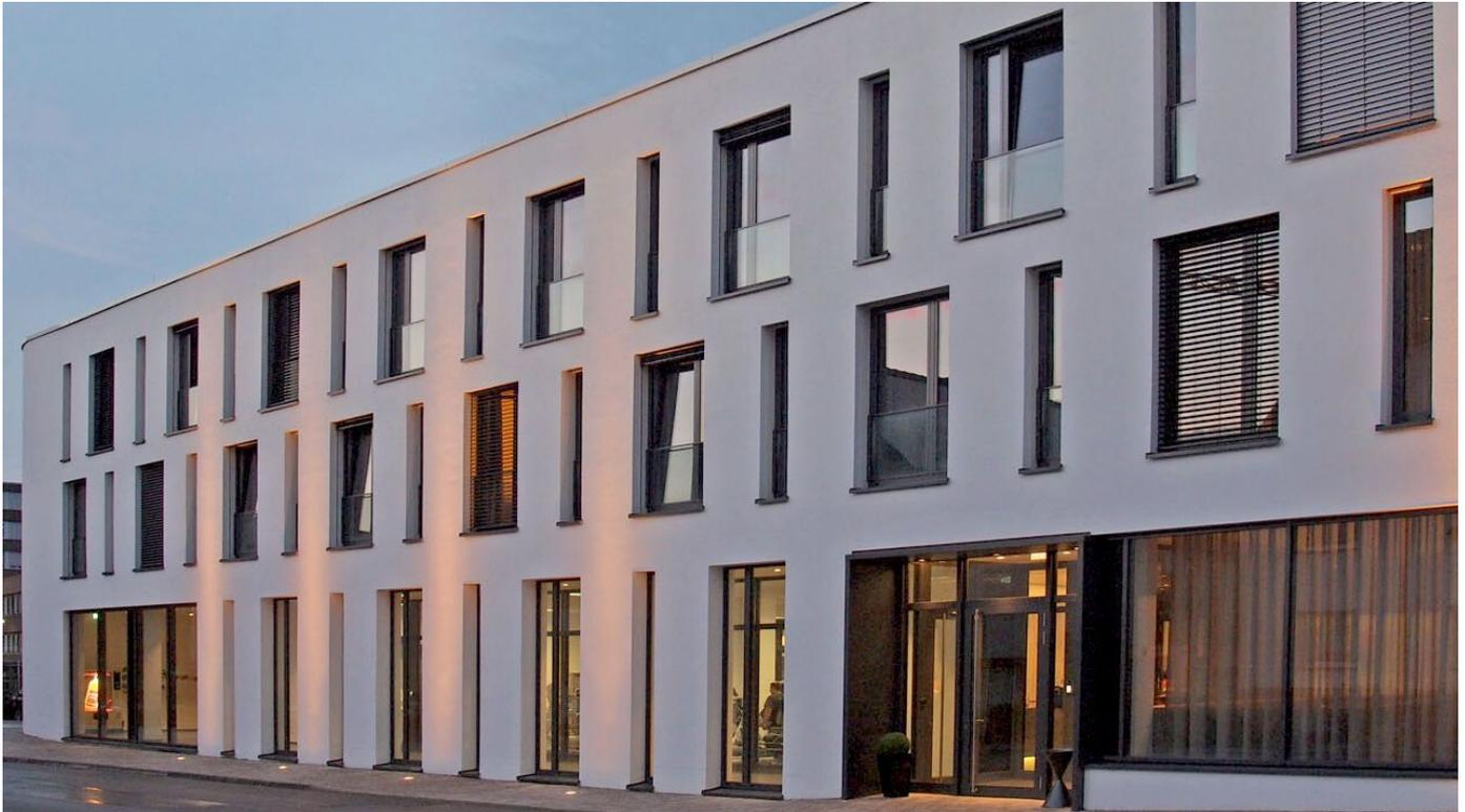
Fenster- und Türsystem aus Aluminium mit 75 mm Bautiefe mit  $U_f$ -Werten bis  $0,86 \text{ W/m}^2\text{K}$  sowie als hochwärmegedämmte Konstruktion Lambda WS/DS 090 mit 90 mm Bautiefe bis Passivhaustauglichkeit  $U_f = 0,7 \text{ W/m}^2\text{K}$ . Einbruchhemmend bis RC3, mit schmalen Ansichten für eine moderne Architektur. Ergänzend dazu Konstruktionen in verschiedenen Bautiefen mit variabler Wärmedämmung für viele Anwendungen wie Verbundfenster, Senk-Klapp- oder Parallel-Ausstell-Fenster.
